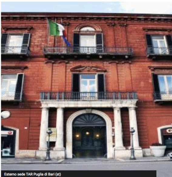
Esterno sede TAR Puglia di Bari (st)
